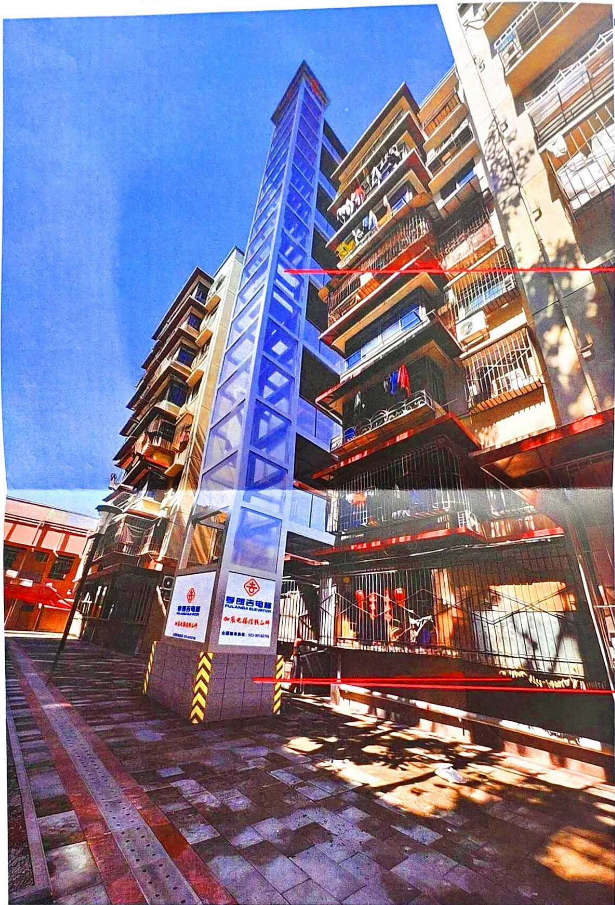
九龙坡区文化一村17栋2单元既有住宅增设电梯项目效果图
