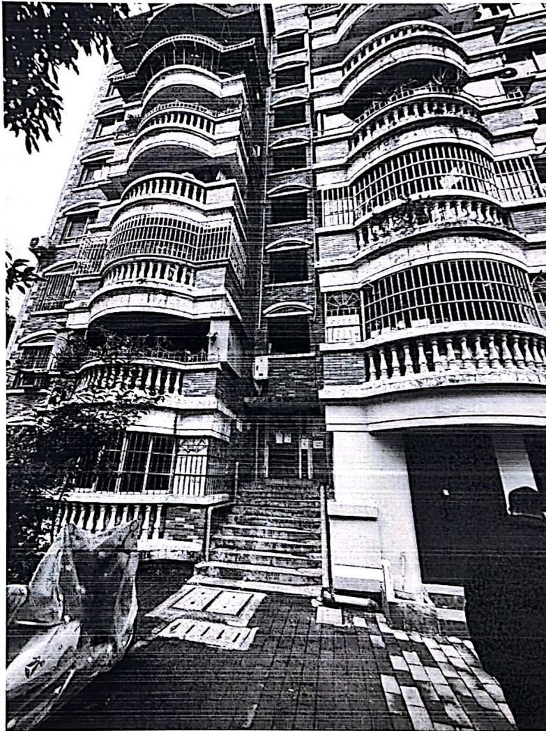
图 1-1 九龙坡区顺通花园 34 栋 1 单元外观图
