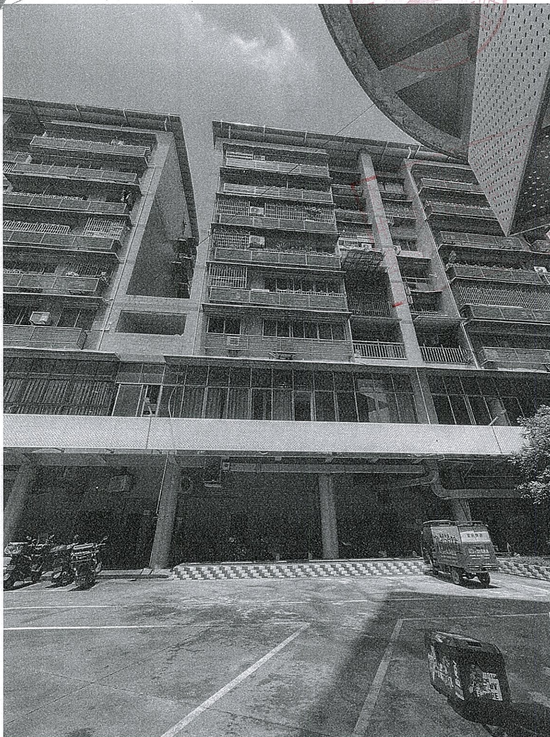
图 1.1 拟加装电梯建筑物现状
